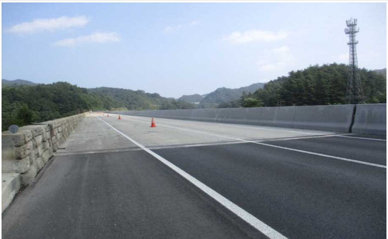
교량 상부 전경
